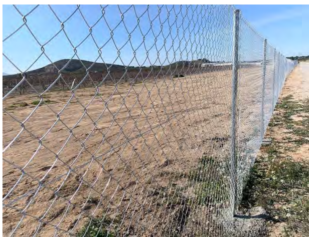
Ilustración 5. Cerramiento perimetral de valla torsión simple.
